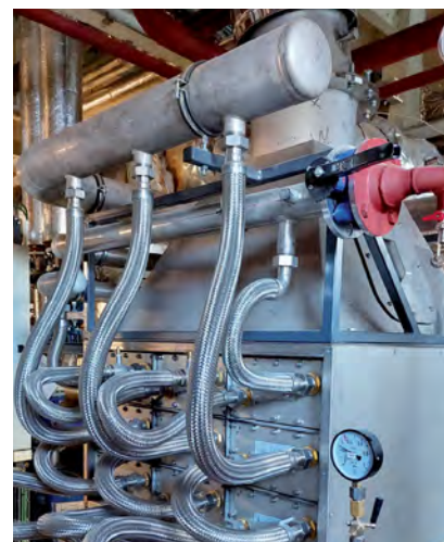
Obr.4 RECOLINE ako ekonomizér kogeneračnej jednotky
